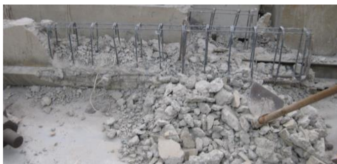
Figura 3-20 - Demolição da viga de betão armado
